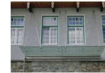
Dank Ausladungen bis 2000 mm eröffnen sich völlig neue Einsatzmöglichkeiten. Diese Variante ist als komplette Garnitur mit Glaswandverbinder erhältlich.
