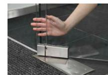
Die Lösung besteht darin, dass ein Teil des Türblattes separat im Grundbeschlag über eine zusätzliche Drehachse gelagert wird.
