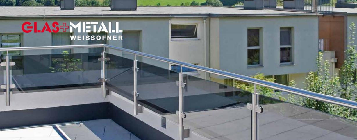
EDELSTAHLKONSTRUKTION MIT DUNKLER GLASFÜLLUNG UND KLEMMHALTER SOWIE RUND- ODER RECHTECKPROFIL
