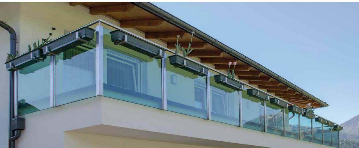
EDELSTAHLKONSTRUKTION MIT BUNTER GLASFÜLLUNG UND KLEMMHALTER SOWIE RUND- ODER RECHTECKPROFIL
