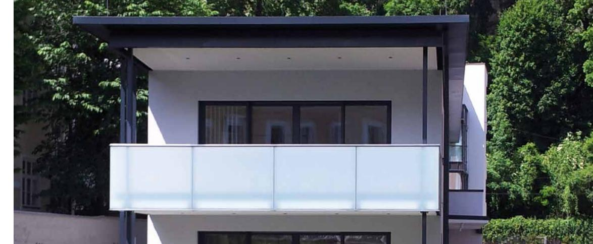
EDELSTAHLKONSTRUKTION MIT VORGESETZTER TRANSLUZENTER GLASFÜLLUNG
