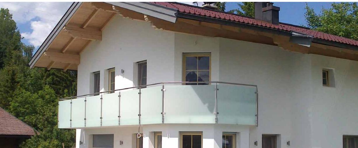
EDELSTAHLKONSTRUKTION MIT HELLER GLASFÜLLUNG UND KLEMMHALTER SOWIE RUND- ODER RECHTECKPROFIL
